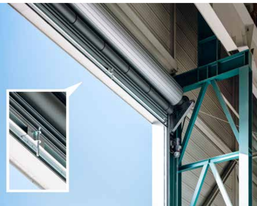
Das Tor erhielt zusätzliche Bodenverankerungen, die in extra gebohrten Ankeraufnahmen laufen
